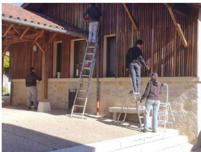
Traitement de la façade de la salle des fêtes
